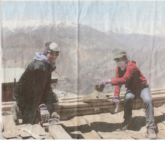
Reparaturarbeiten am Dach der Welt und am Dach der einzigartigen Tempelanlage an der Seidenstraße: Wiener Forscher prüfen die Statik
